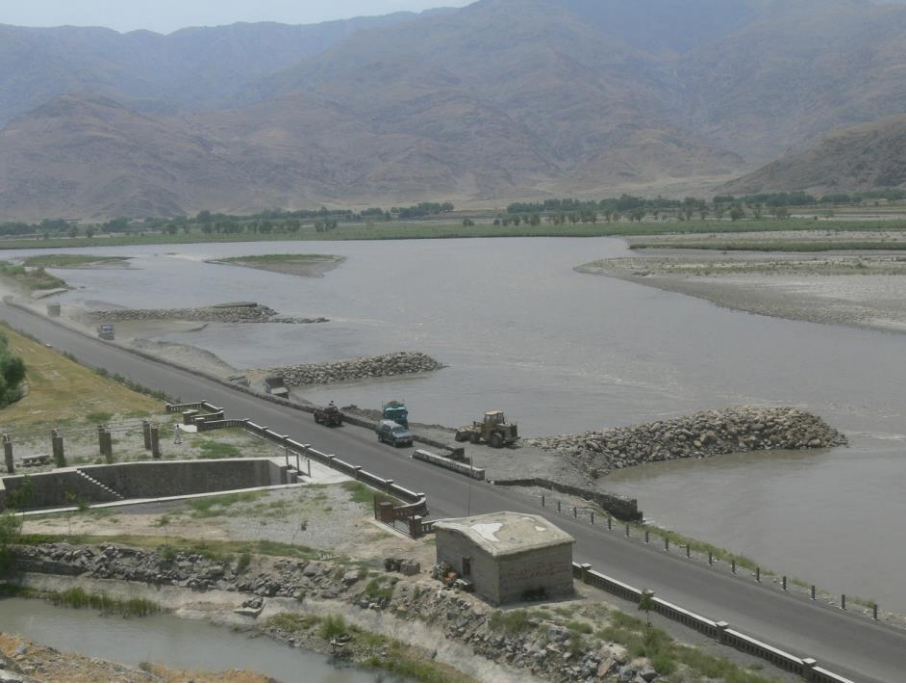
石出し水制（クナル河）用水路 Canal from Kunar River
